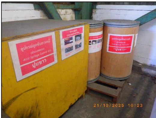
รูปที่ 2.32 อุปกรณ์ตอบโต้สารเคมีหกรั่วไหล
