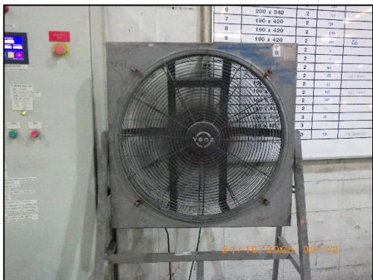
รูปที่ 2.38 พัดลมระบายอากาศภายในอาคาร
