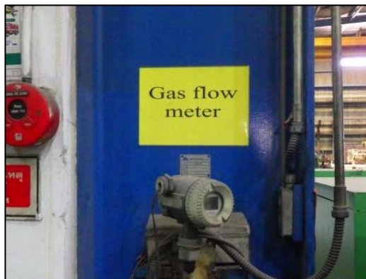
รูปที่ 2.51 Gas flow meter
